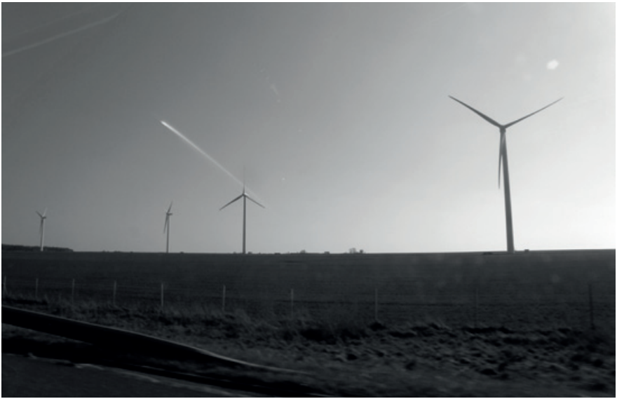
Des capteurs, quelque part entre LISBONNE et EVORA, Portugal, Octobre 2011. Crédit photo : Jean-Yves Quay, architecte et urbaniste.
