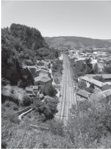
La ligne ferrée traverse la montagne, TOURNON, sortie Nord du tunnel SNCF, Ardèche, Mai 2009. Crédit photo : Jean-Yves QUAY, architecte urbaniste.
