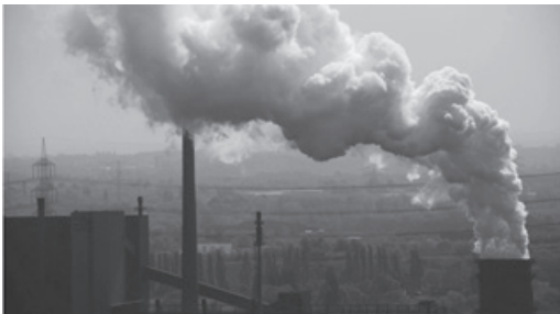
Les usines au Emscher Park (Allemagne) Crédit photo : Yves Hubert
